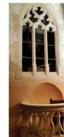
Taille d'éléments d'un réseau gothique sur plan courbe, reprise et raccords des éléments taillés par des stagiaires de l'Atelier de la Pierre. Reprises et restauration d'un fenestrage gothique réalisé par des stagiaires de l'Atelier de la Pierre, reprise des courbes, raccords, joints, comblements en pierre reconstitué et ragréage.
