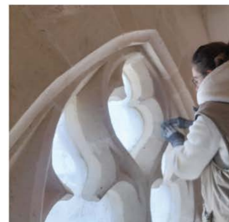
Taille d'éléments d'un réseau gothique sur plan courbe, reprise et raccords des éléments taillés par des stagiaires de l'Atelier de la Pierre. Reprises et restauration d'un fenestrage gothique réalisé par des stagiaires de l'Atelier de la Pierre, reprise des courbes, raccords, joints, comblements en pierre reconstitué et ragréage.
