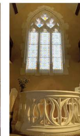
Taille d'éléments d'un réseau gothique sur plan courbe, reprise et raccords des éléments taillés par des stagiaires de l'Atelier de la Pierre. Reprises et restauration d'un fenestrage gothique réalisé par des stagiaires de l'Atelier de la Pierre, reprise des courbes, raccords, joints, comblements en pierre reconstitué et ragréage.
